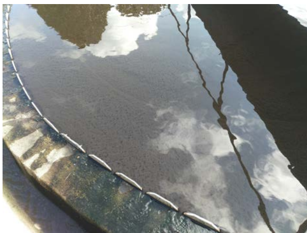
Figura 5: Intumescimento ocorrido no decantador secundário.
