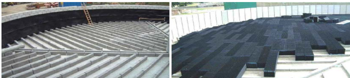
Figura 2: Vigas ou blocos pré-moldados na laje de fundo do filtro para apoiar o meio suporte plástico estruturado e paredes laterais em alvenaria e em placas pré-fabricadas, sem função estrutural
