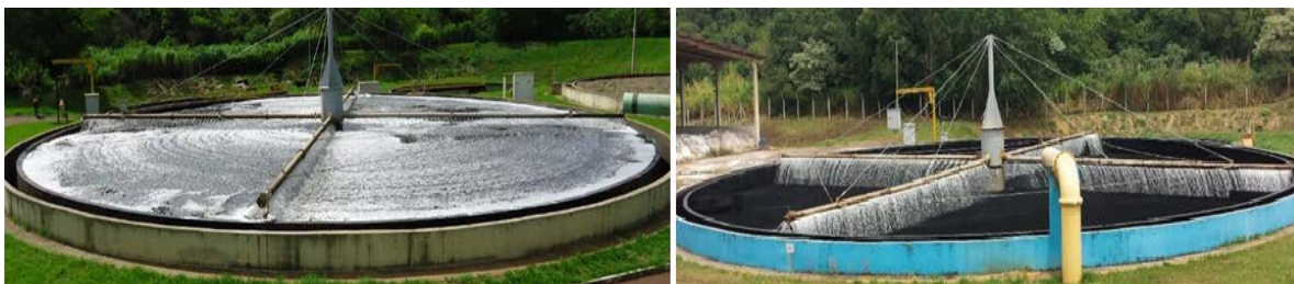
Figura 4: Filtro perclador antes e depois da substituição do meio suporte colmatado
