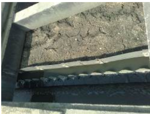
Figura 3: Espuma espessa acumulada no decantador anaeróbico (a) e gasômetros fechados (b) na ETE A.
