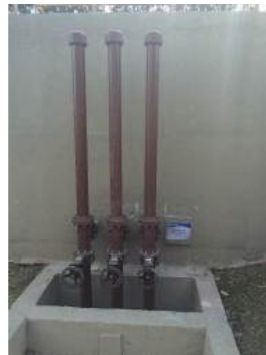
Figura 2: Tampa e interior do gasômetro (a) e amostradores de lodo (b) da ETE D.
