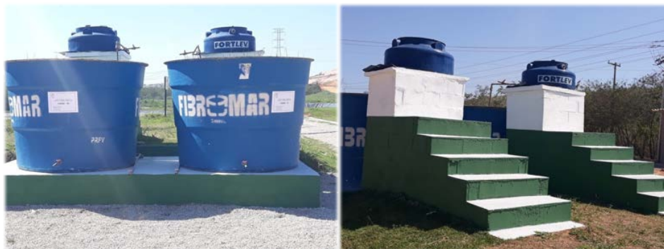
Figura 01 – Caixas 1 e 2 de 5.000 L cada, onde está sendo realizada a irrigação diária do lixiviado oriundo da lagoa aerada.
