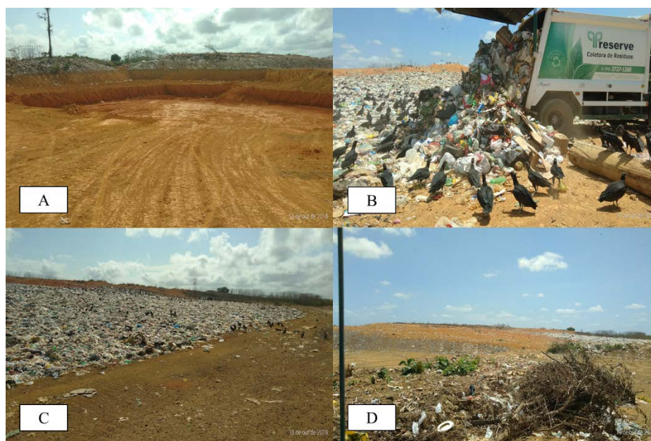
Figura 5: A) Célula sendo preparada para receber resíduos sólidos; B) Deposição de resíduos sólidos em célula receptora; C) Célula receptora de resíduos; D) Célula receptora de resíduos após o processo de compactação dos resíduos.
