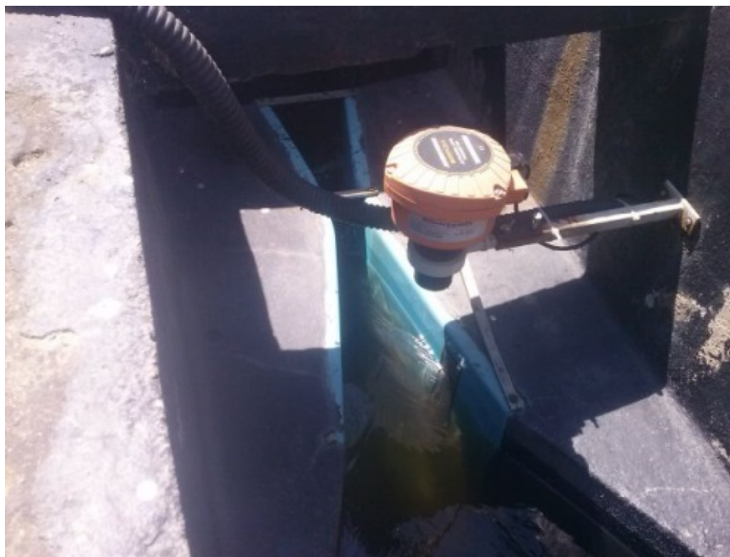
Figura 5 - Medidor automático (ultrassônico) de vazão não operacional na ETE Vilar Carioca
