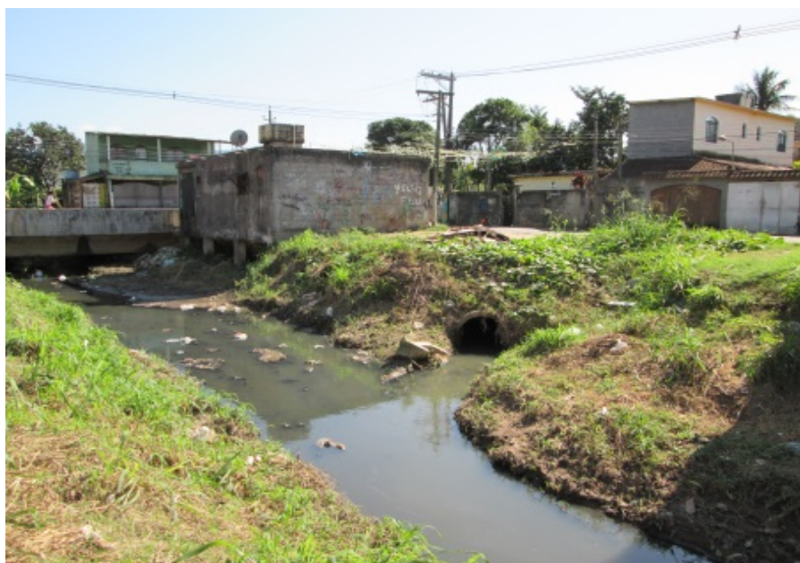
Figura 2: Valão no município de Itaguaí-RJ, onde desaguardam os esgotos captados via rede de drenagem
