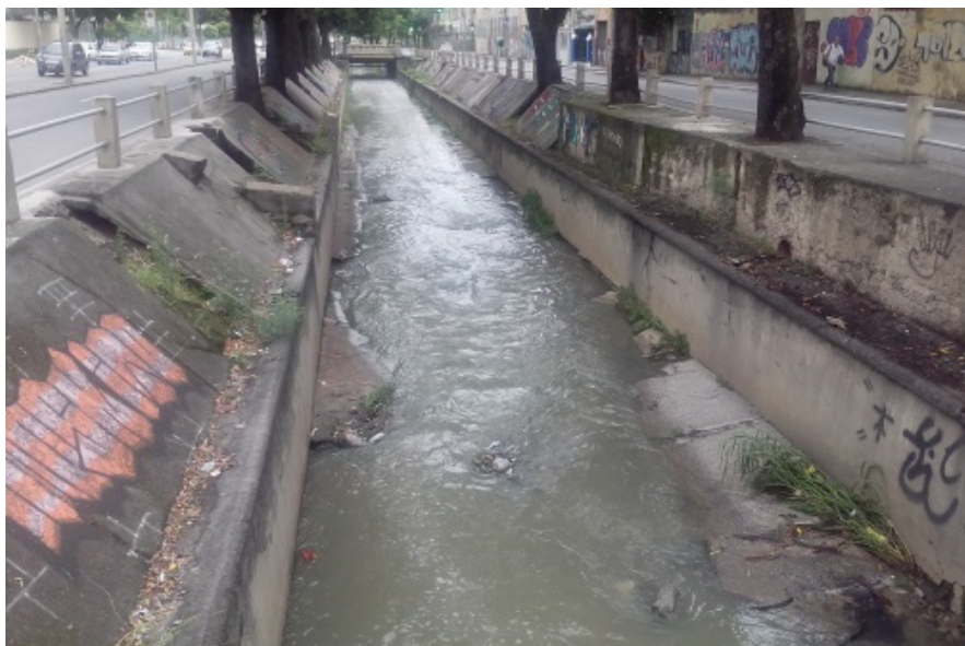
Figura 1: Trecho do Canal do Rio Maracanã no bairro da Tijuca, RJ, tomado por esgotos sanitários, mesmo com existência de rede separativa
