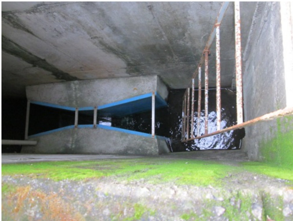
Figura 4 – Calha Parshall na ETE Nova Cidade Figura
