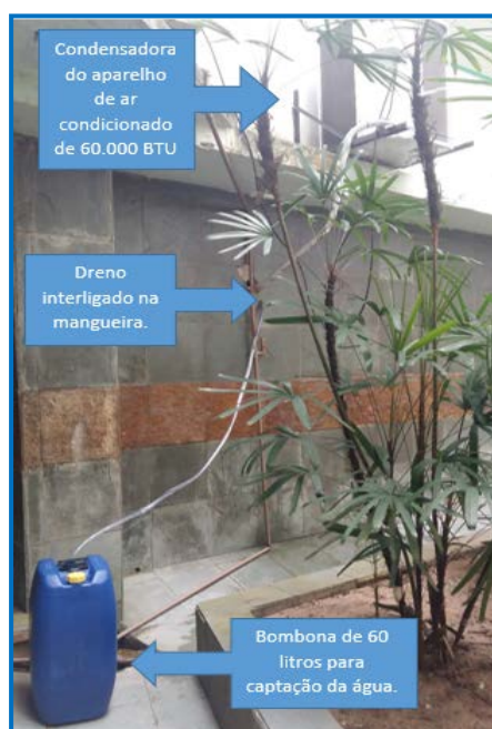
Figura 1: Sistema de captação da água condensada.
