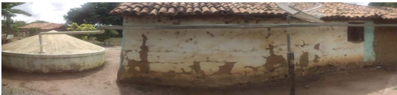
Figura 1: Ilustração geral das condições estruturais e higiênico-sanitárias das cisternas das comunidades Mata Velha e Minguiriba, Chapada do Araripe, CE: (a) precárias condições do sistema de captação de água, (b) calha improvisada e antiga que conduz água para cisternas (c) balde para retirar água em desuso, (d) presença de partículas suspensas na água e (e) instalação de cisternas próximas a banheiros.
