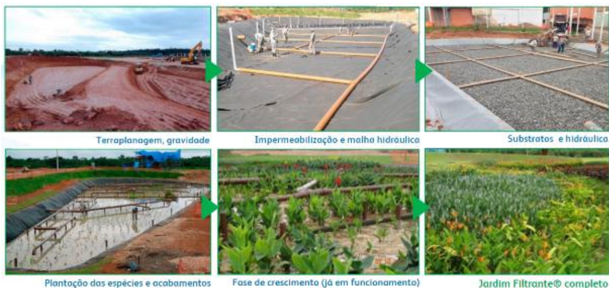
Figura 17: Fase de implantação das lagoas em cinco estágios.
