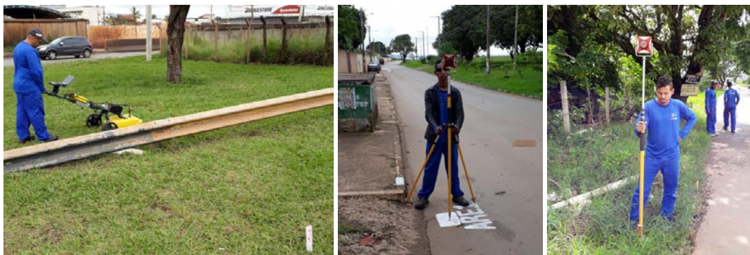
Figura 1: Fotografias da equipe de campo fazendo o levantamento da rede pressurizada
