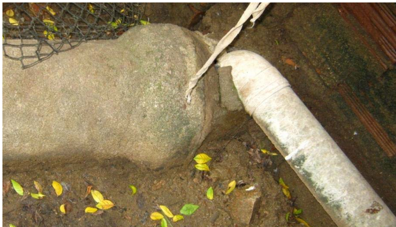
Figura 9 – Ligação do ramal interno com a rede coletora de esgoto.
