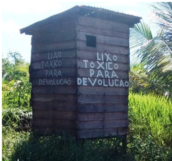
Figura 5: Mini instalação suspensa para armazenagem de resíduos tóxicos.
