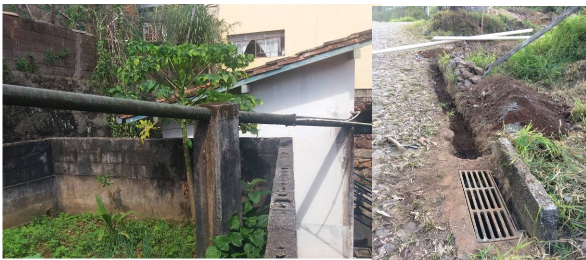
Figura 4 - a) à esquerda, na Associação de Moradores Bairro São Cristóvão tubulações áreas; b) à direita, ligação da rede de esgotamento sanitário a rede de drenagem pluvial no bairro Passa Dez (Chico Rei).
