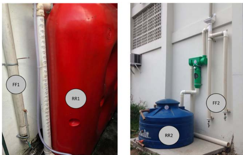
Figura 2: Sistema de Captação e Armazenamento CAP1 e os pontos de coleta FF1 e RR1 (à esquerda) e do sistema CAP2 e os pontos de coleta FF2 e RR2 (à direita).
