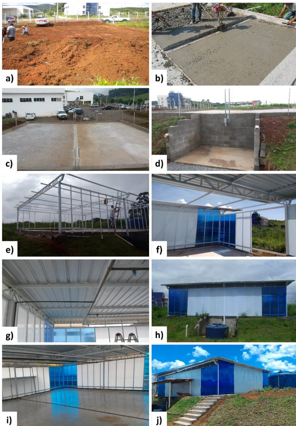
Figura 1 – Fotografias da construção do simulador de chuva: a) local de construção; b) concreto da base impermeável; c) base impermeável; d) exutório da bacia experimental; e) base de metal leve para suportar a estrutura de acrílico; f) construção de acrílico; g) vista parcial da tubulação de PVC e dos bocais; h) vista frontal do simulador de chuva; i) vista interior do simulador de chuva; j) vista externa do simulador de chuva
