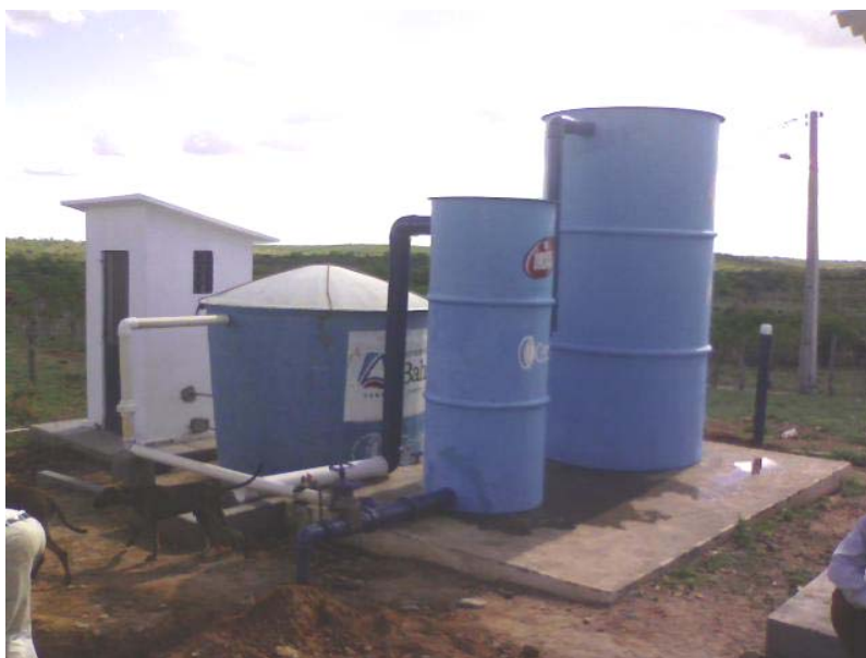
Figura 4 : Unidade de tratamento por dupla filtração instalada
