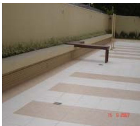
Figura 6: Ralos localizados no pavimento térreo
