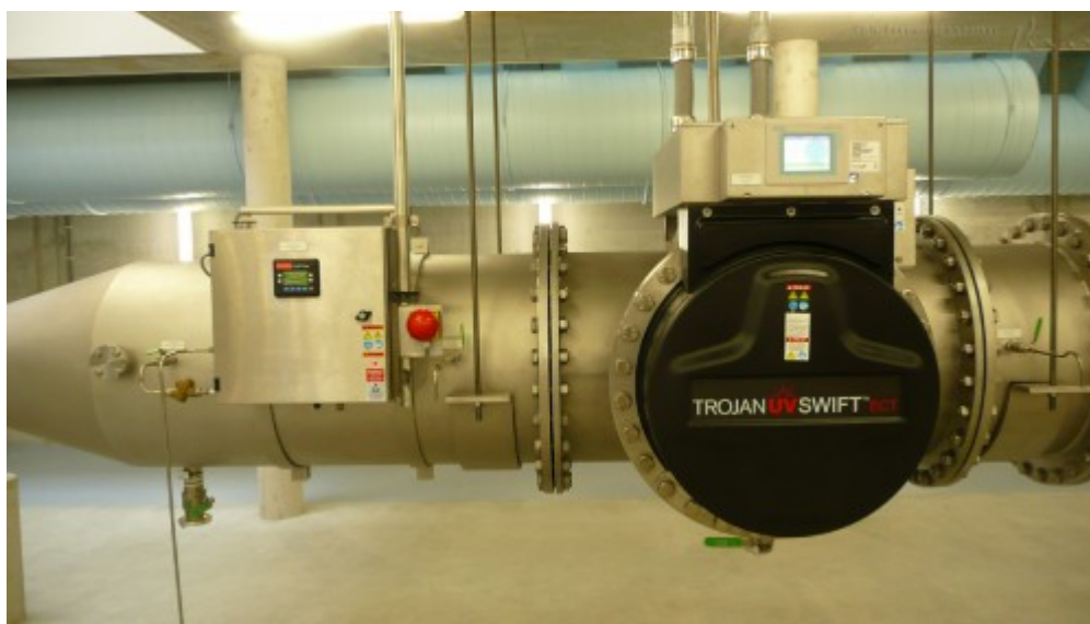
Figura 4: Um dos quatro foto-reatores em série na aplicação de peróxido de hidrogênio foto-ativado com UV em ETA da PWN (Holanda).
