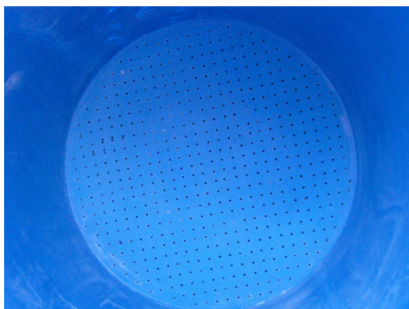
Figura 3 – Foto do sistema de distribuição de fundo (fundo falso com orifícios de 3/8").
