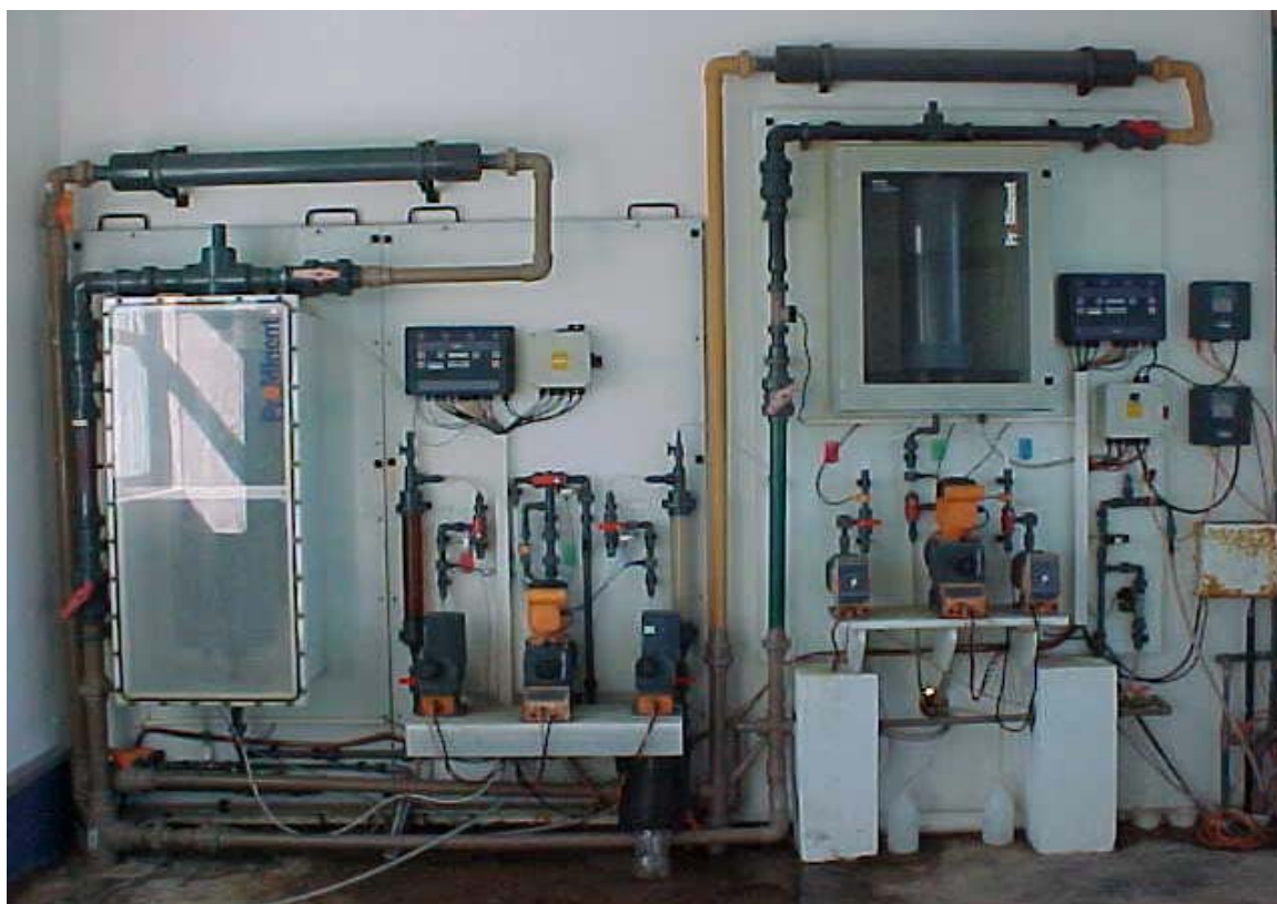
Figura 1. Fotografia dos dois sistemas geradores de dióxido de cloro usados pela COMUSA (à esquerda, tem-se o gerador de capacidade igual a 6.000g.h -1 ; à direita, tem-se o gerador de capacidade igual a 1.500g.h -1 de geração de solução de dióxido de cloro).
