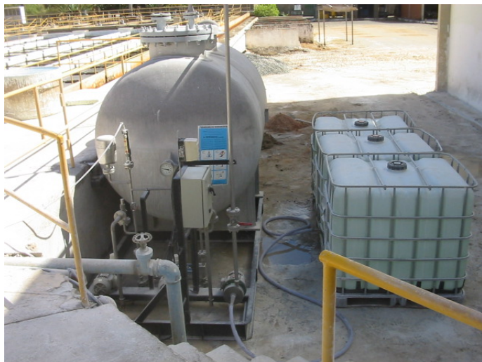
Figura 3: Aplicação de peróxido de hidrogênio na pré-oxidação em ETA.
