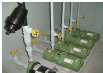
Figura 12: Bombas usadas para o sistema de captação de água de chuva
