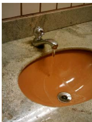
Figura1-Vazamento Pia Bloco I Térreo
