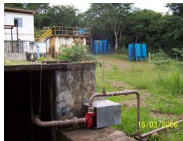
Figura 5: Poço de sucção instalado na captação de água bruta
