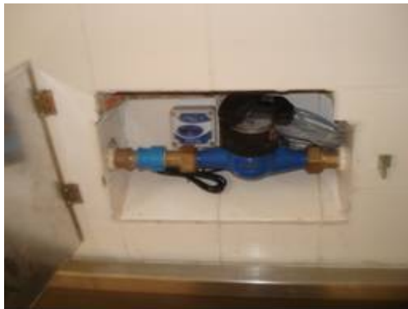
Figura 3: Hidrômetros e dataloggers instalados nos sanitários masculinos.
