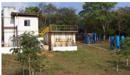
Figura 1: Vista da instalação com FiME piloto em paralelo com a ETA convencional em Goianápolis.
