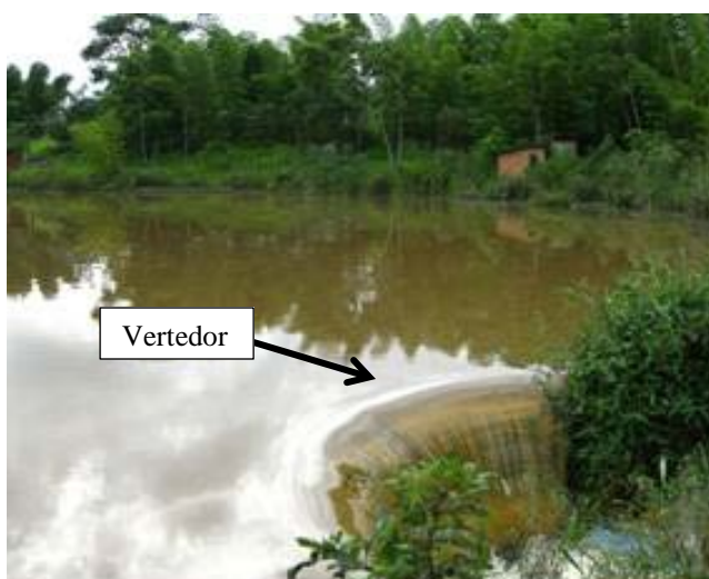
Figura 1- Represa Samambaia. Detalhe: Vertedor
