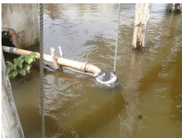
Figuras 3 e 4: Em Anamã a boca do poço PT-03 já submersa protegida apenas com saco plástico e do poço PT-04 com o nível superior às águas superficiais
