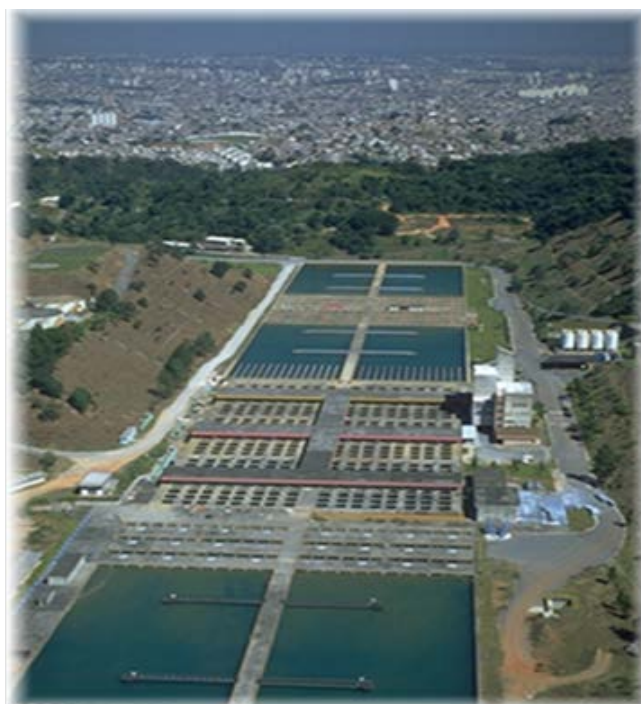
Figura 2: Vista dos decantadores da ETA Guaraú.
