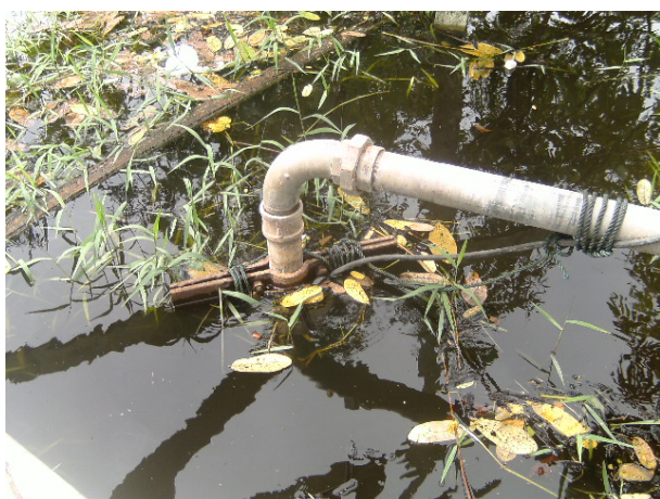
Figuras 1 e 2: Em Anori a boca do poço PT-06 completamente submersa e do poço PT-08 (sem tampa de proteção) ainda não coberta pela águas superficiais
