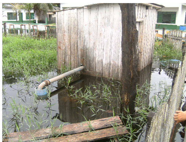
Figuras 1 e 2: Em Anori a boca do poço PT-06 completamente submersa e do poço PT-08 (sem tampa de proteção) ainda não coberta pela águas superficiais
