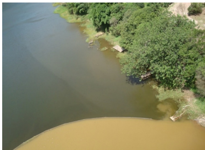
Figura 1: Aplicação da cortina de turbidez na obra do trecho Sul do Rodoanel. (Fonte: IPT, 2008).
