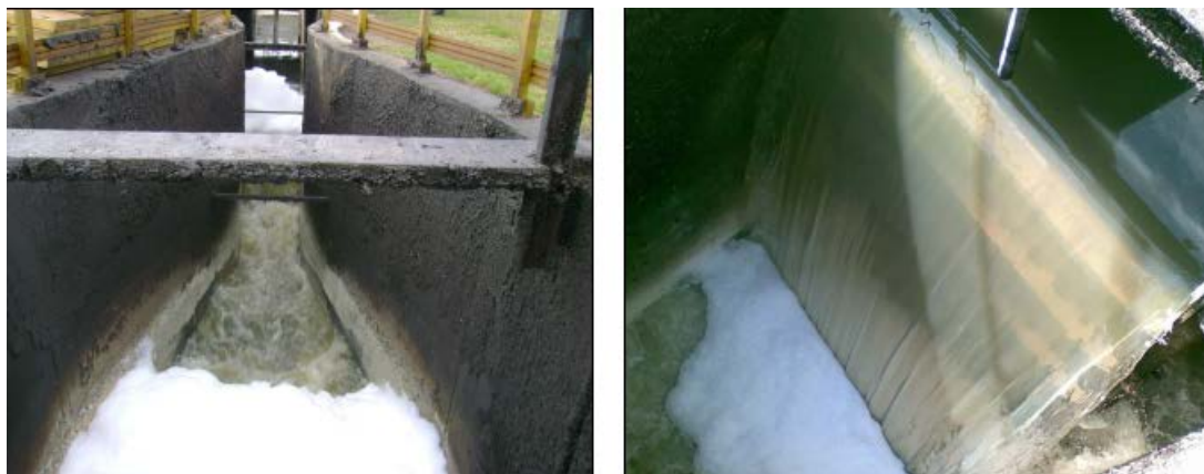
Figuras 1 e 2: Ressalto hidráulico e comporta na saída das lagoas, respectivamente.
