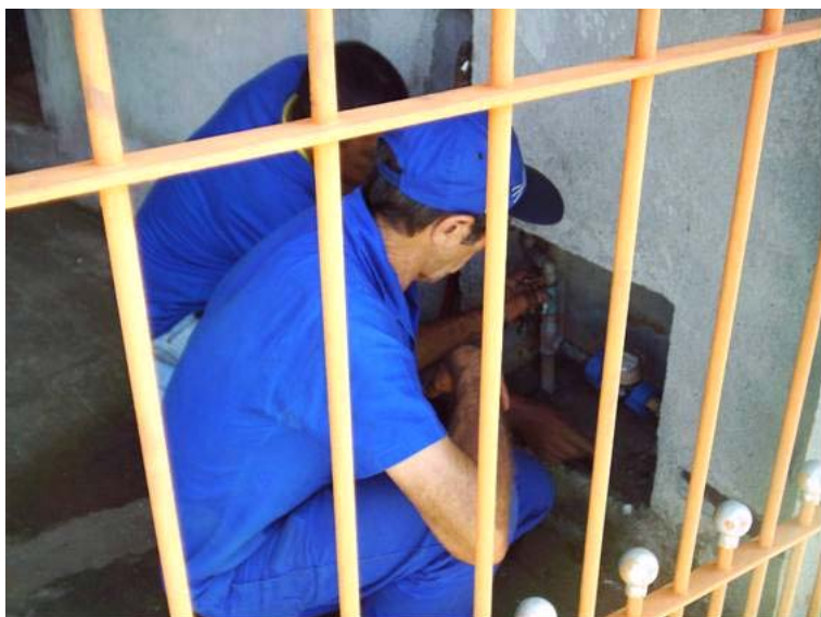
Foto 02 – Equipe realizando leitura do hidrômetro no início dos testes
