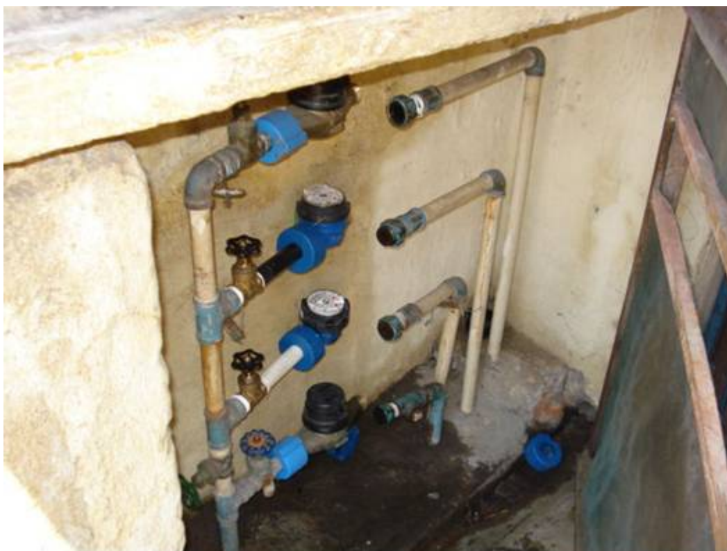
Foto 04 – Ligação de água desconectada durante o teste
