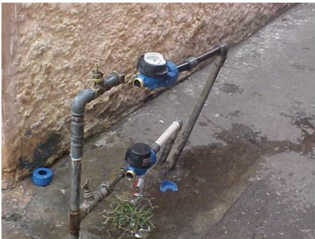
Foto 05 – Ligação de água desconectada durante o teste
