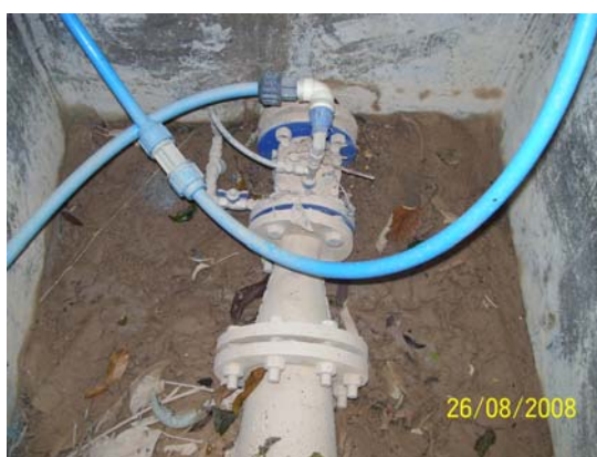
Figura 2 – Válvula hidráulica de controle de nível instalada na tubulação de entrada do reservatório.
