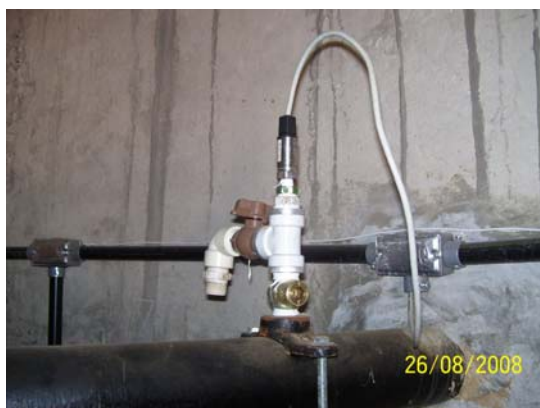
Figura 1 – Sensor de pressão instalação na tubulação de recalque de água.
