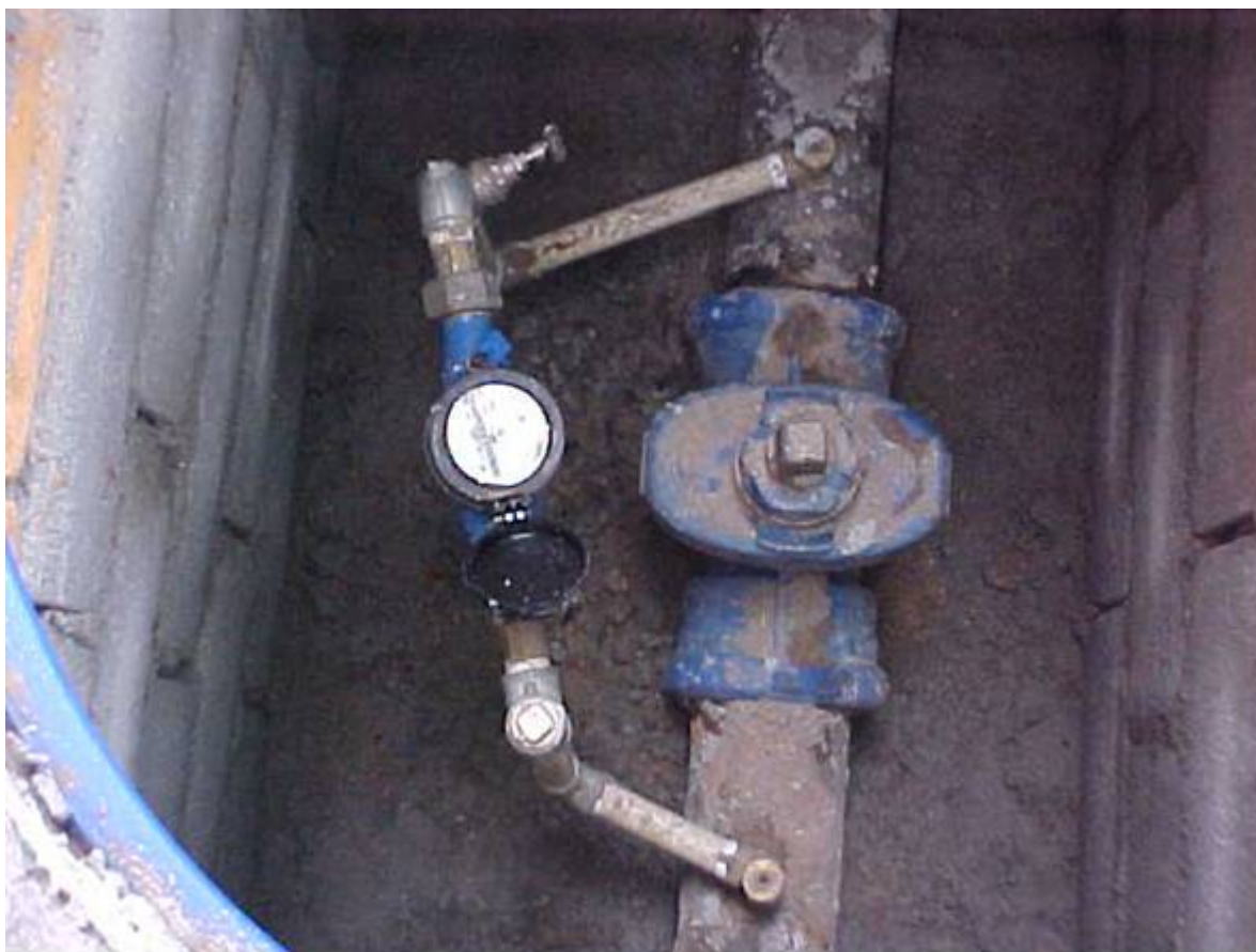
Foto 03 – Detalhe do By – Pass e medidor instalado Teste Rua Boca da Mata
