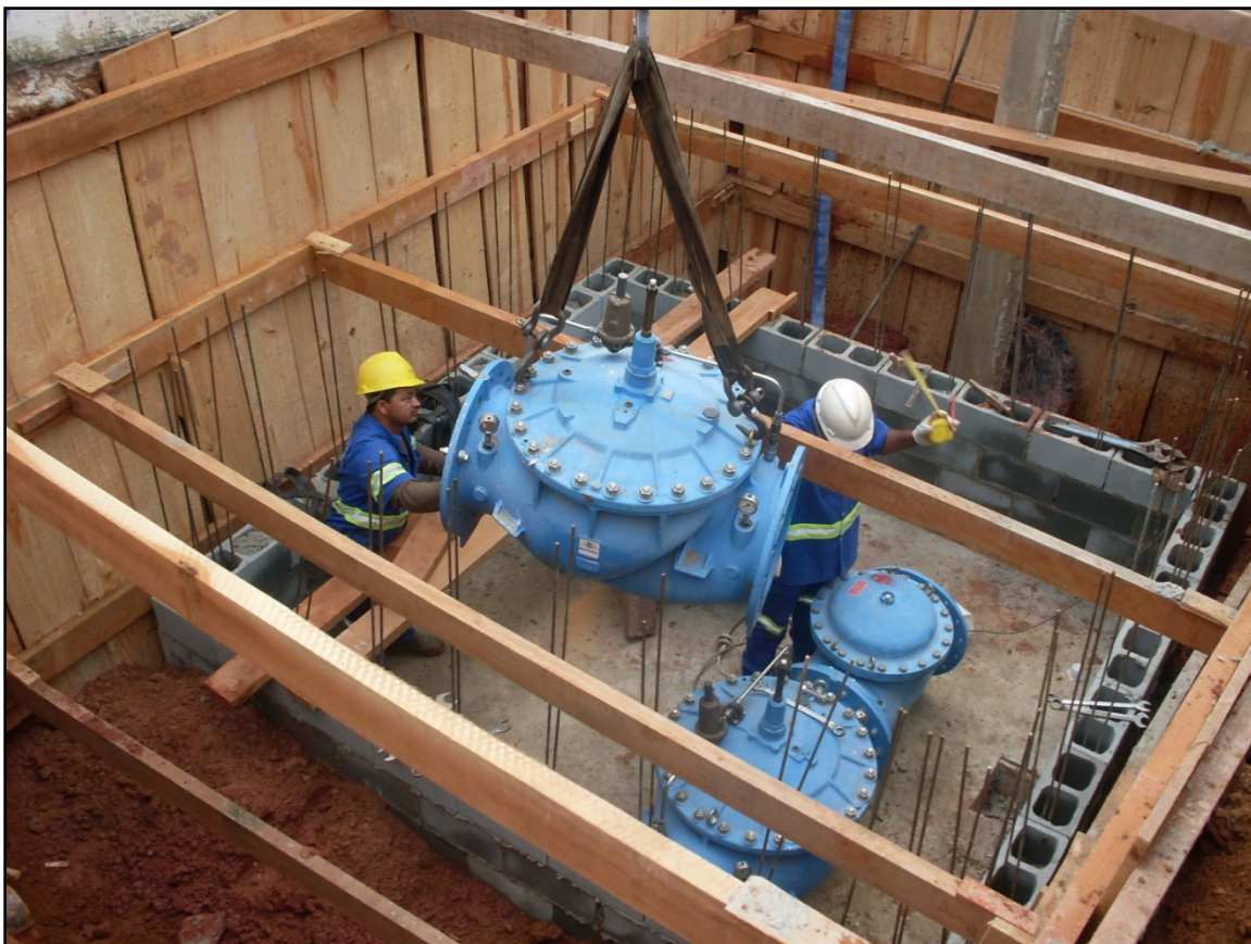
Figura 1: instalação da vrp com cobertura de 30% do setor de abastecimento Cachoeirinha – (Fonte: Sabesp - MN)
