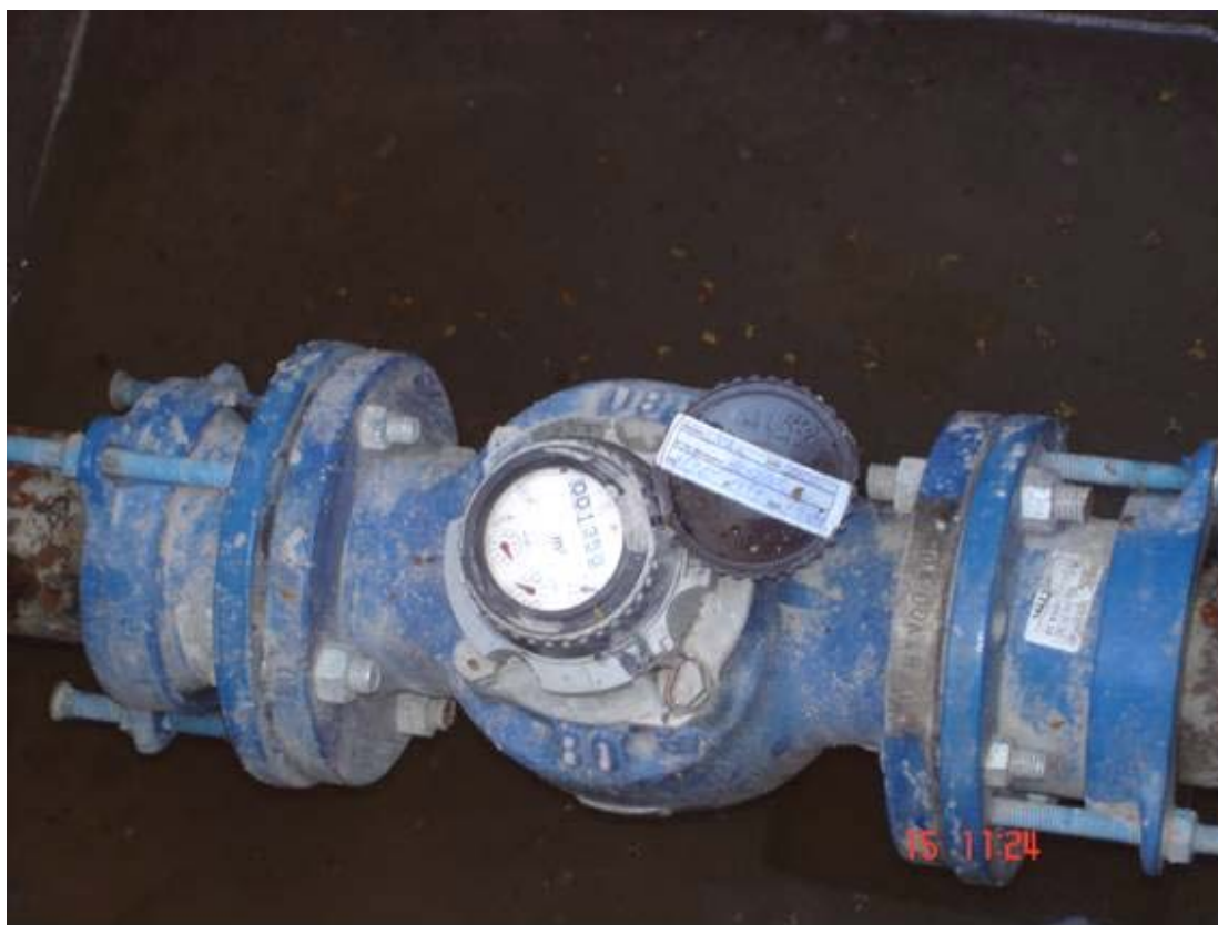
Foto 01 – Hidrômetro da VRP, utilizado para leitura do teste
