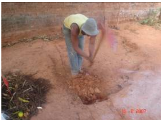
Figura 7: Escavação manual das valas .
