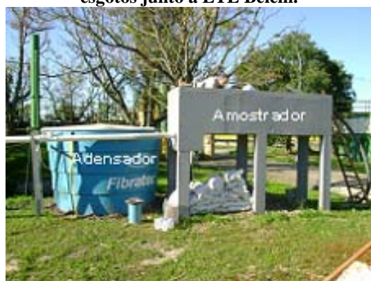
Figura 2 – Sistema amostrador seguido por adensador.
