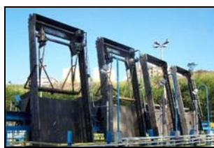
Foto 2: Grades finas mecanizadas.
