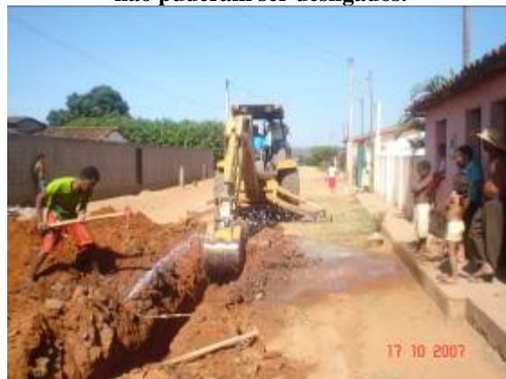
Figura 13: Escavação das valas para instalação da rede nas ruas – detalhe de um dos ramais que não puderam ser desligados.
