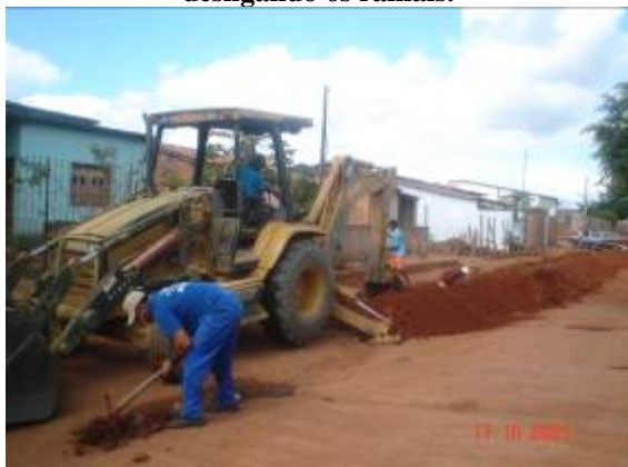
Figura 12: Escavação das valas para instalação da rede nas ruas – detalhe do trabalhador desligando os ramais.
