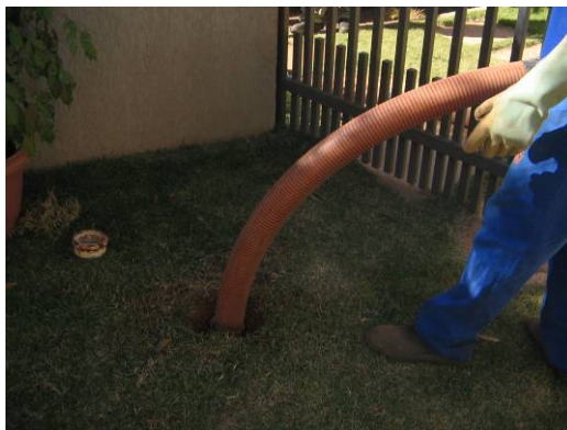
Figura 1 - Limpeza de uma fossa séptica residencial.
