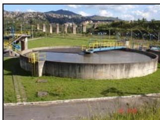
Foto 9: Adensador de lodo por gravidade.
