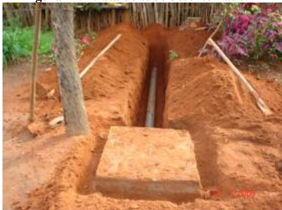
Figura 14: Vista do tubo desenterrado.
