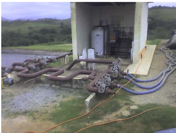
Sistema de aplicação, mistura e injeção de polímero.
