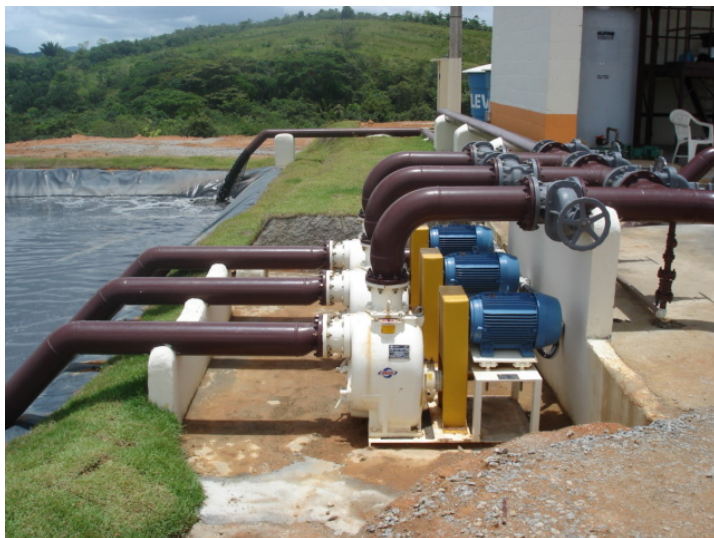
Sistema de recirculação e bombeamento, e lagoa de homogeneização.
