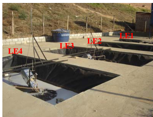
Figura 2 -(a) vista do aerador (b) Lagoas aeradas (LE1, LE3 e LE4)
