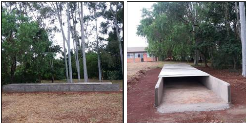
Figura 1: Composteira em alvenaria e com telhado removível.
