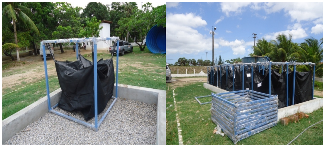
Figura 1: Estrutura utilizada no deságue do lodo séptico na ETE Metrópole, Caucaia - CE
