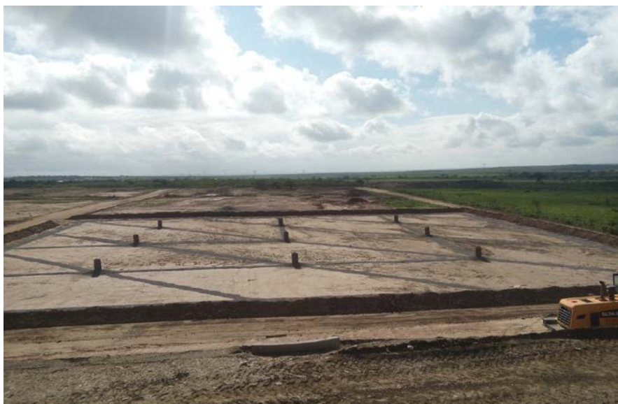
Figura 2: Configuração do sistema de drenagem de lixiviado.
