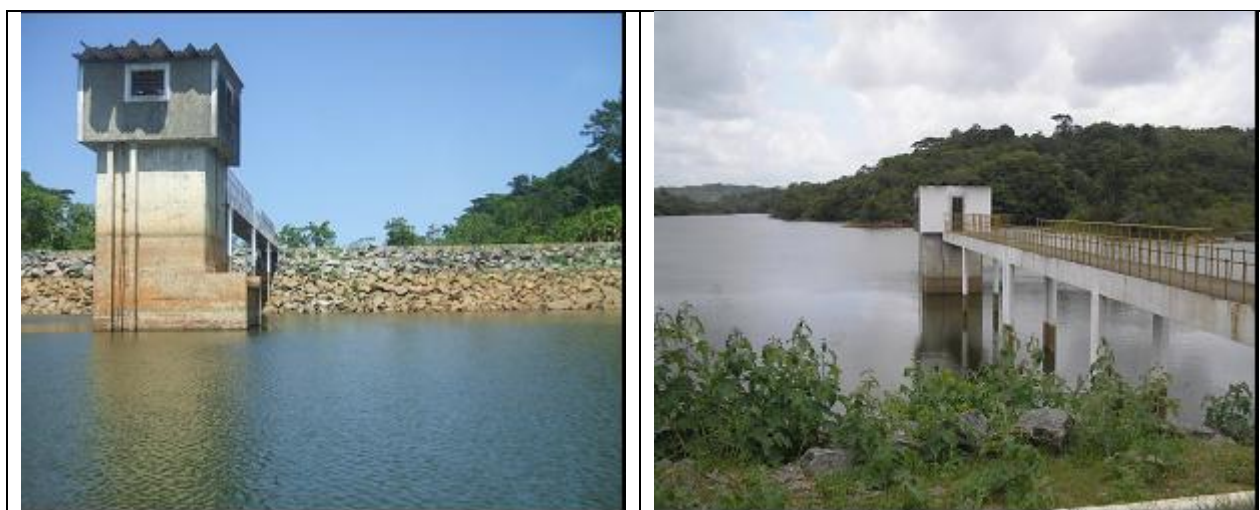
Figura 6 – Vista da captação da água bruta da ETA SUAPE na barragem de Bita.
