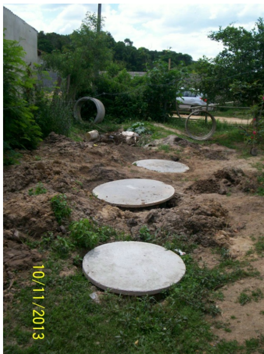
Figura 11 - Residência em fase final de implantação da fossa séptica.
