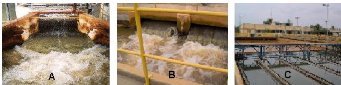
Figura 1-ETA Capim Fino: (A) – Canal de entrada de água bruta; (B) – Floculador; (C) Decantador.
