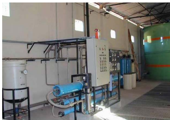
Figura 4 - Sistema de osmose reversa. Fonte: Novelis
