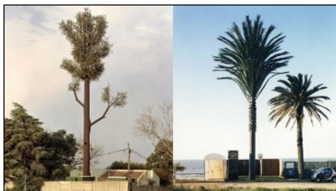
Figura 4: Estação Rádio Base camuflada - Alemanha
