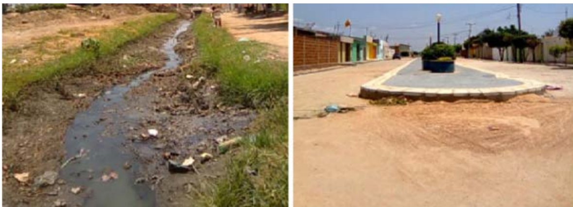
Figura 6: trecho natural do canal do Julião e galeria de concreto armado do canal da Bastiana.
