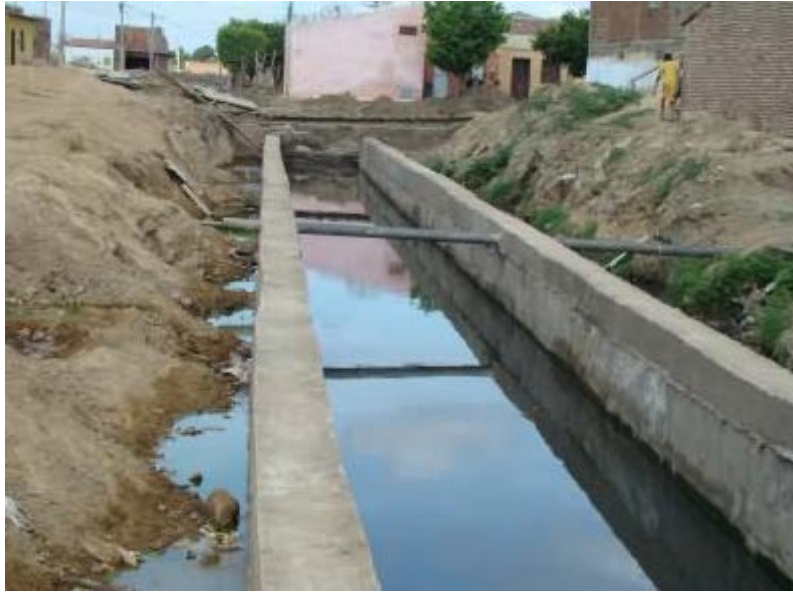
Figura 4: Canal da Bastiana em construção. Fonte: Prefeitura de Iguatu-CE.
