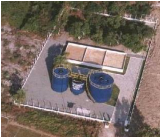
Biofiltros aerados submersos
