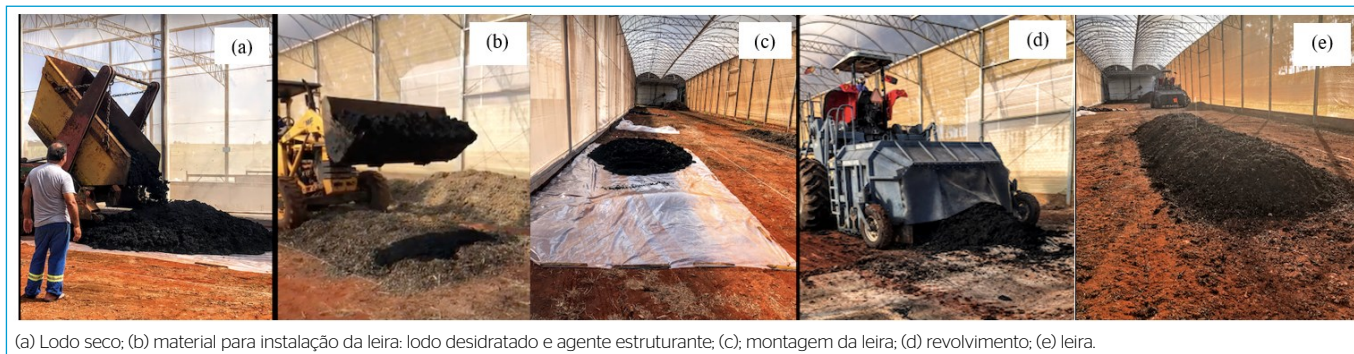
Figura 3 - Instalação do sistema compostagem.
