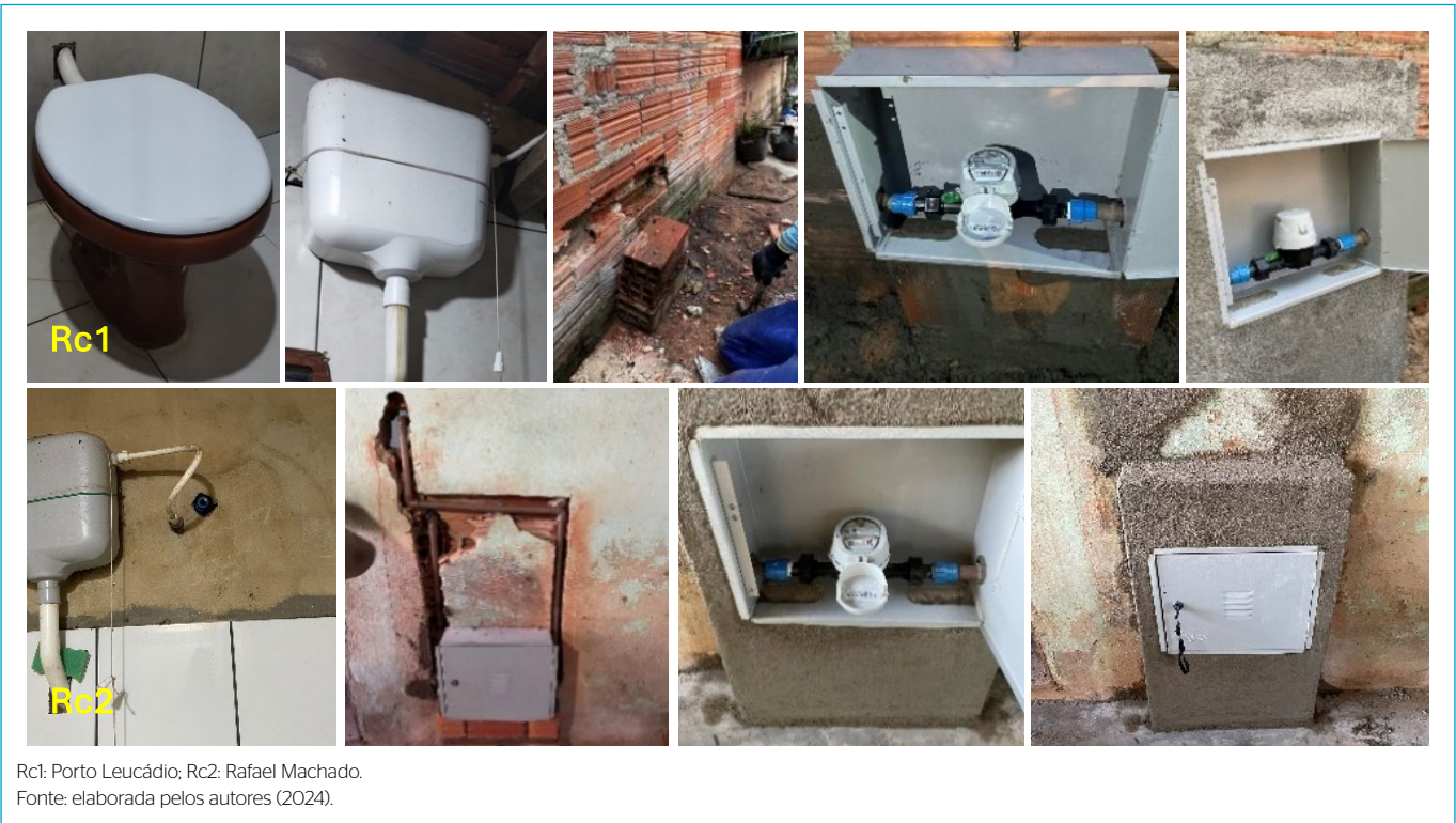
Figura 2 - Derivação na tubulação, com a instalação de um hidrômetro volumétrico antes do vaso sanitário, para registrar o volume de água gasto nas descargas
