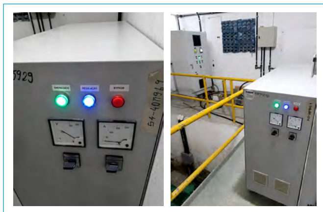
Figura 6 – Regulador BT/BT (P1 Rio Real)
