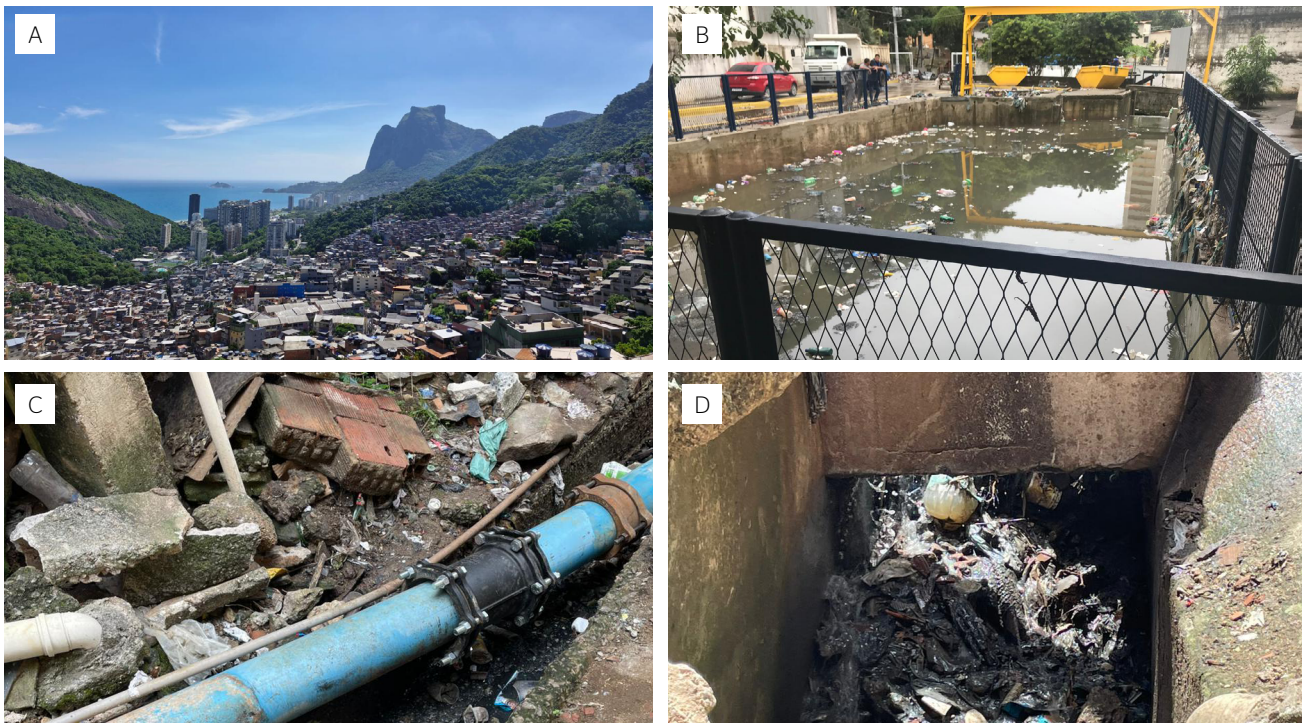
Figura 2 - Realidade do saneamento na Rocinha. (A) Vista da comunidade, evidenciando a ocupação urbana densa e a complexidade topográfica; (B) canal de drenagem com acúmulo de resíduos sólidos; (C) canal de águas residuárias com presença de tubulação de abastecimento de água e resíduos; (D) vista do interior de uma caixa-rato, evidenciando poluição e acúmulo de resíduos
