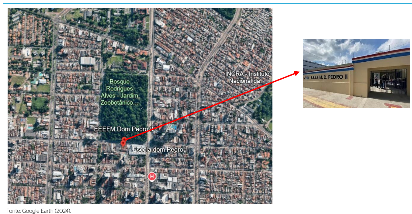
Figura 1 – Localização e fachada da referida EEEFM Dom Pedro II
