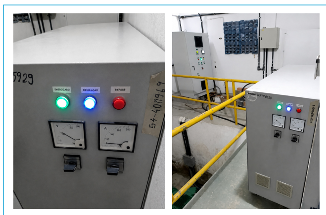
Figura 6 – Regulador BT/BT (P1 Rio Real)
