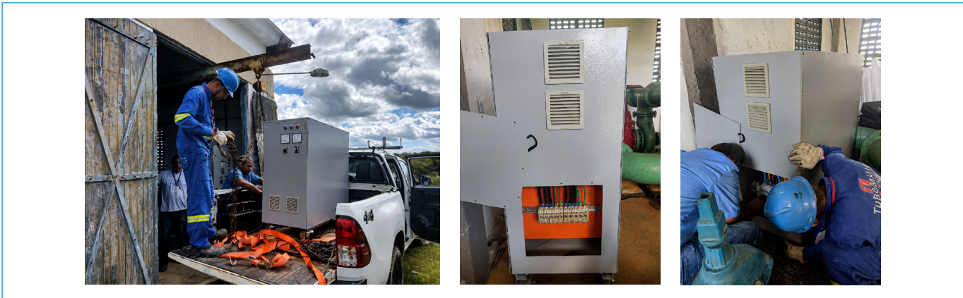
Figura 5 - Instalação do regulador BT/BT
